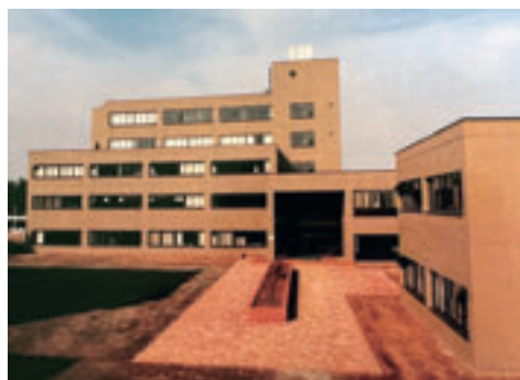
建築中の医短大部棟 (村井提供)
